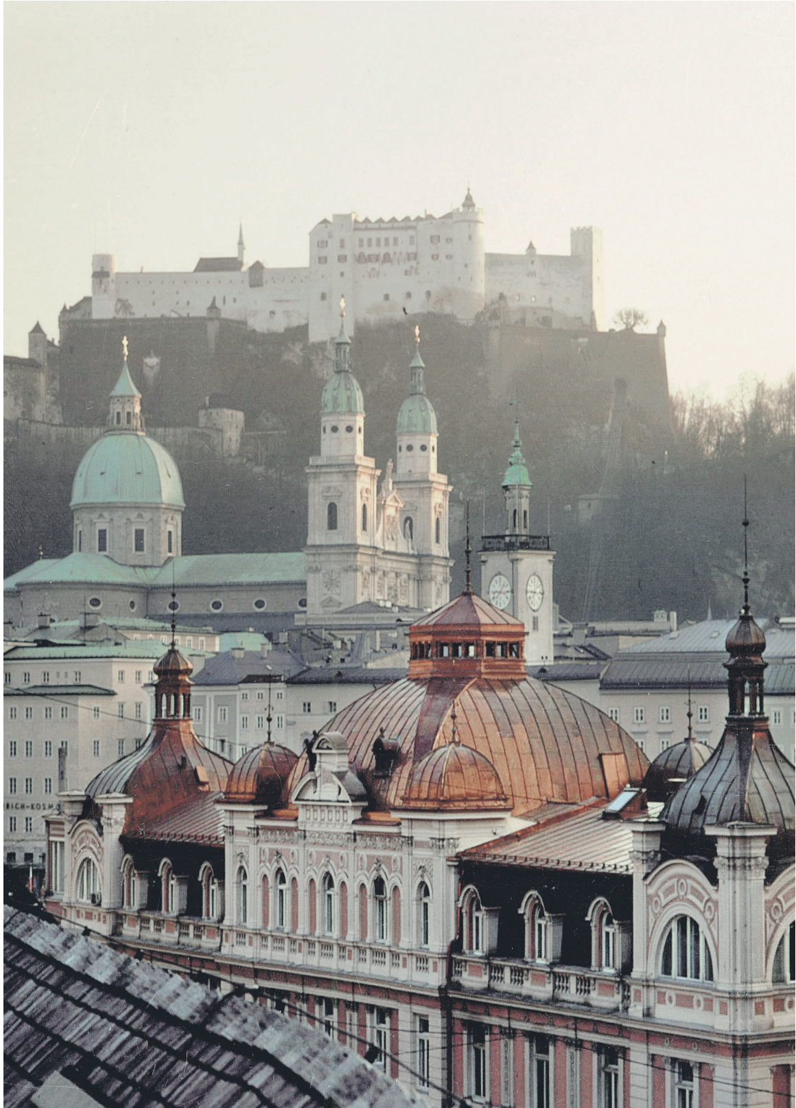
Das Bankhaus Spängler ist mit insgesamt rund 260 Mitarbeitern an Standorten in Stadt und Land Salzburg, Linz, Wien, Graz, Innsbruck und Kitzbühel vertreten. Direkt an der Staatsbrücke in der Stadt Salzburg befindet sich das Stammhaus des Bankhaus Spängler.
